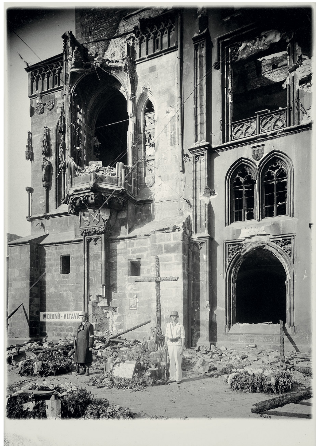
69. Poškozený gotický arkýř Staroměstské radnice a čestná stráž u kříže padlým po skončení Pražského povstání, 1945 Damaged Gothic oriel window of the Old Town Hall and honor guard by cross for the fallen after the Prague Uprising, 1945
